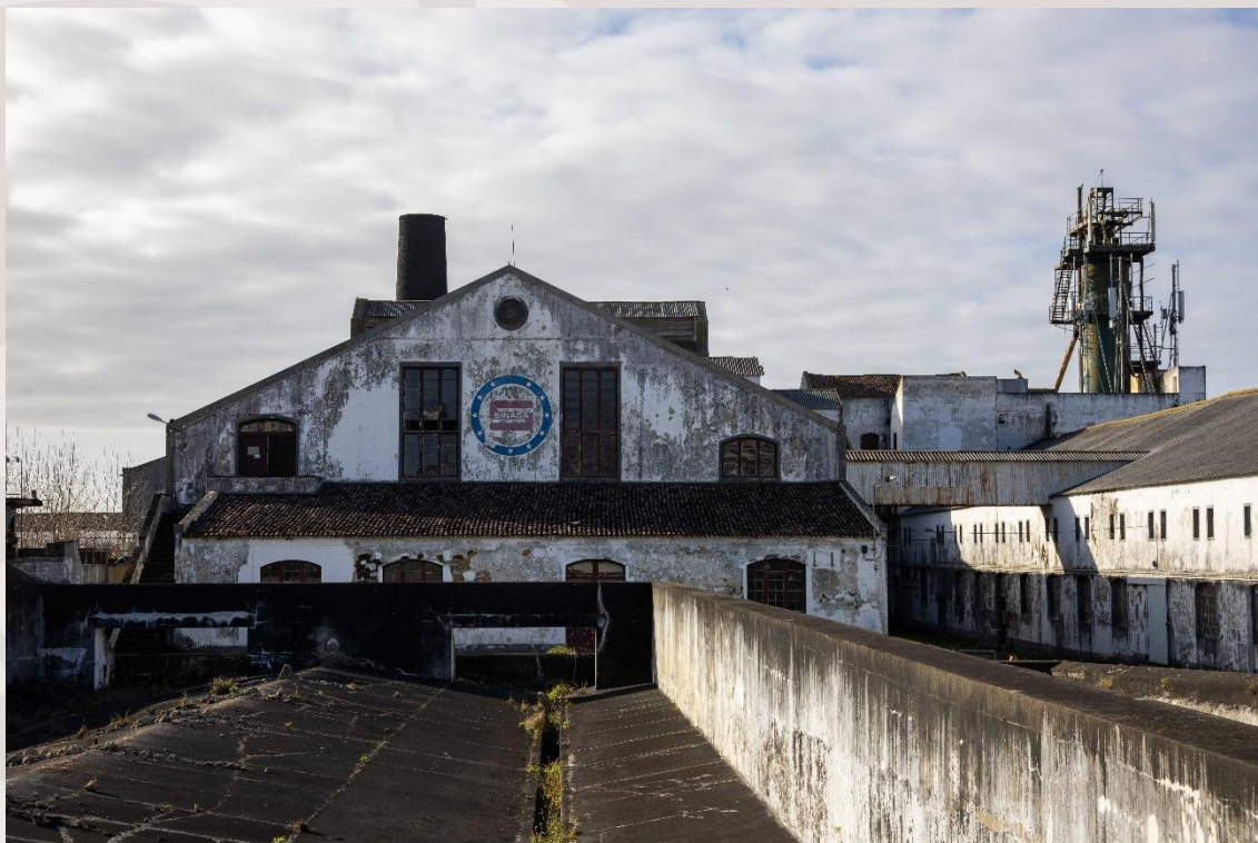
Figura 52 – Vista exterior da antiga Fábrica (edifício 8). Autor: Hugo Moreira
