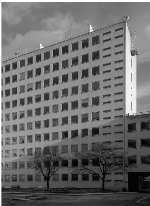
Figura 35 e Figura 36 - l'Îlot Saint-Germain, Paris: de escritórios a habitação multifamiliar. Conversão de um edifício de escritórios devoluto em habitação, adicionando nova fachada para controlo climático passivo e de baixa energia. A estrutura é conservada.
