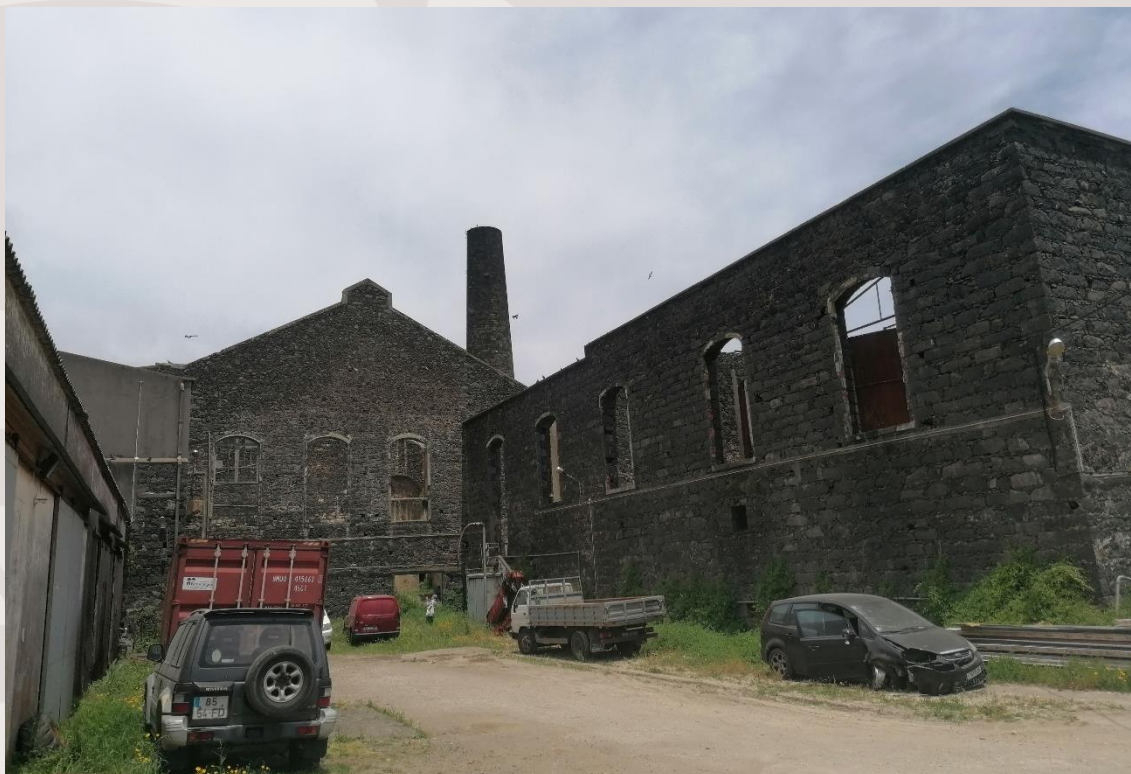
Figura 64 – Vista exterior do edifício primitivo (edifício 14).
