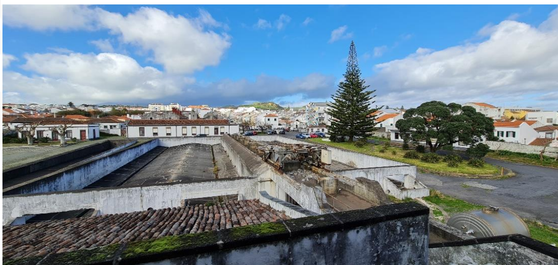
Figura 98 –Silos de beterraba, ano de 2022.
