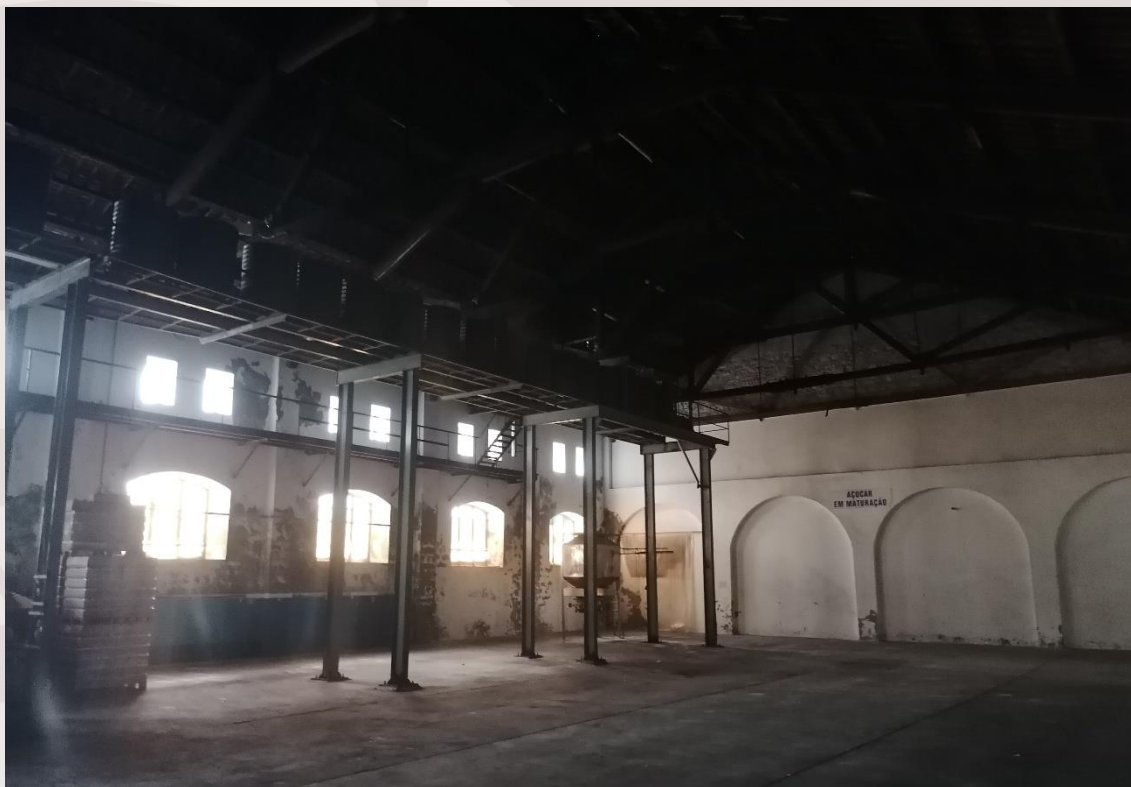
Figura 60 – Interior da sala de embalagem/armazenamento (edifício 9).
