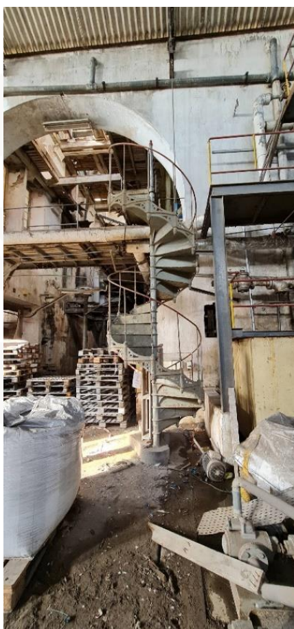
Figura 93 e Figura 94 – Escada em ferro e estruturas e pavimentos em madeira, ano de 2022. Fonte: Arq. a Carolina Cordeiro.
