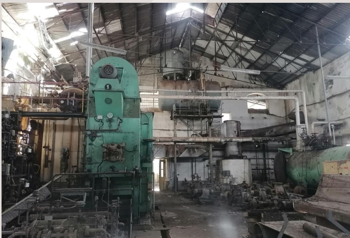
Figura 57 – Interior do edifício da antiga Fábrica (edifício 8.1).
