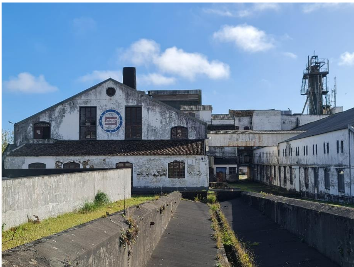
Figura 95 –Fachada norte, ano de 2024. Fonte: Arq. a Carolina Cordeiro.
