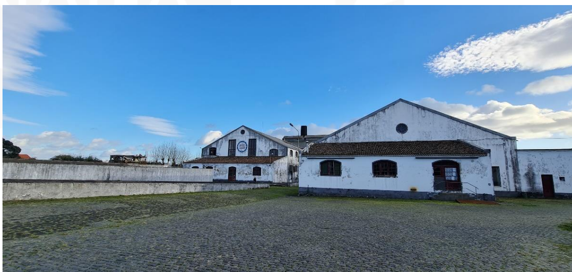
Figura 91 – Fotografia das fachadas norte, ano de 2022.
