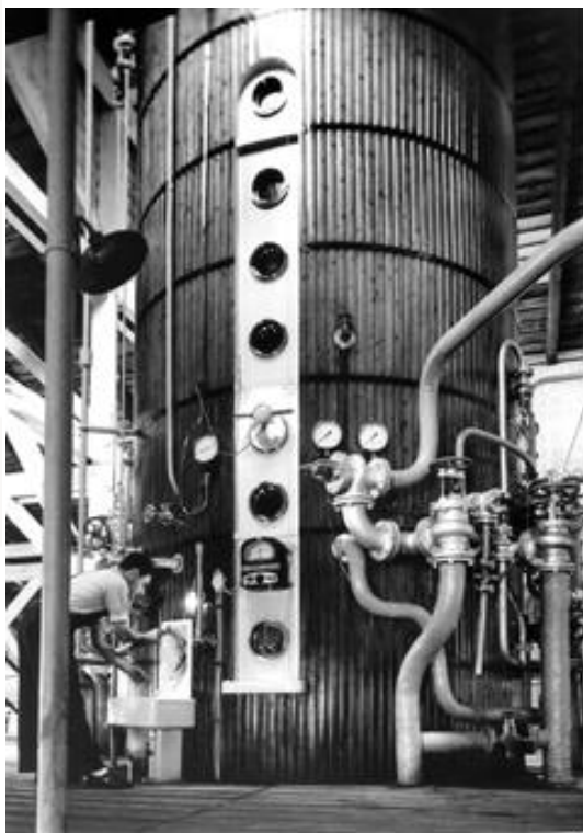
Figura 14 e Figura 15 – Tacho de cristalização a vácuo (esquerda) e aparelhos de saturação com reciclagem (direita).
