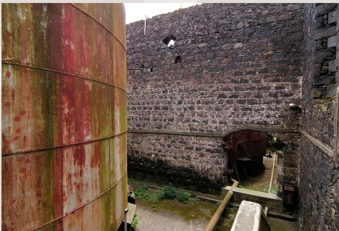
Figura 65 – Interior do edifício primitivo com os tanques (edifício 14).
