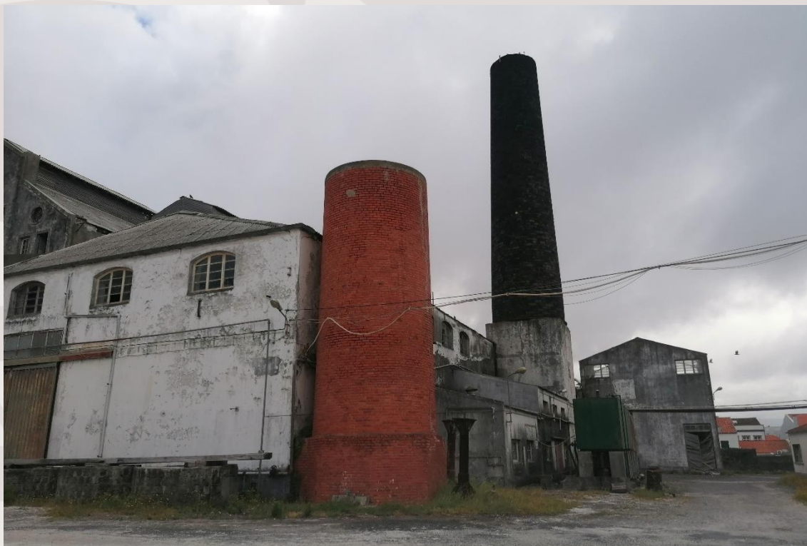
Figura 58 – Vista das chaminés da Fábrica (edifício 8.2).
