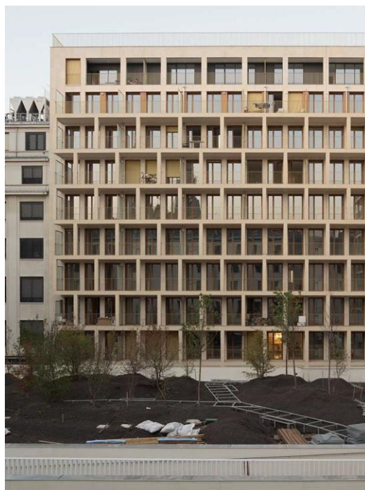
Figura 35 e Figura 36 - l'Îlot Saint-Germain, Paris: de escritórios a habitação multifamiliar. Conversão de um edifício de escritórios devoluto em habitação, adicionando nova fachada para controlo climático passivo e de baixa energia. A estrutura é conservada.
