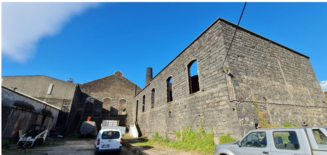
Figura 92 – Alçado edifício sul dos tanques de melaço e fuel, ano de 2022. Fonte: Arq. a Carolina Cordeiro.
