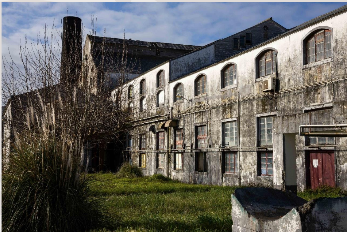
Figura 54 – Vista exterior lateral da antiga Fábrica (edifício 8). Autor: Hugo Moreira
