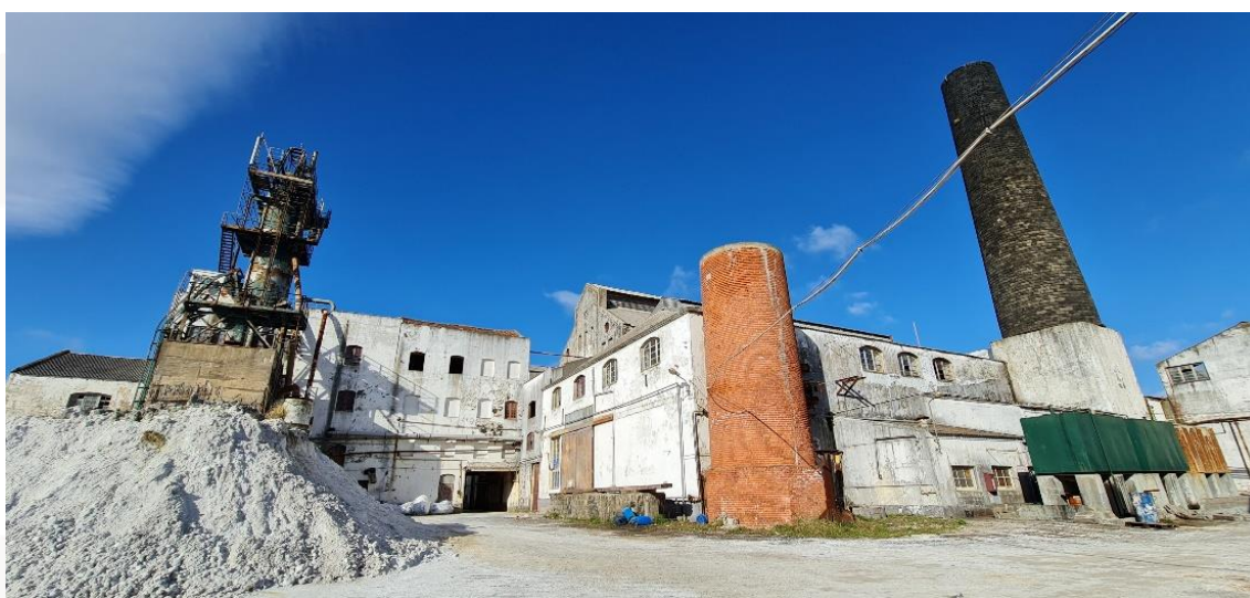
Figura 97 –Alçado sul (esquerda para a direita): forno e tremonha de carregamento da cal, chaminés, ano de 2022.
