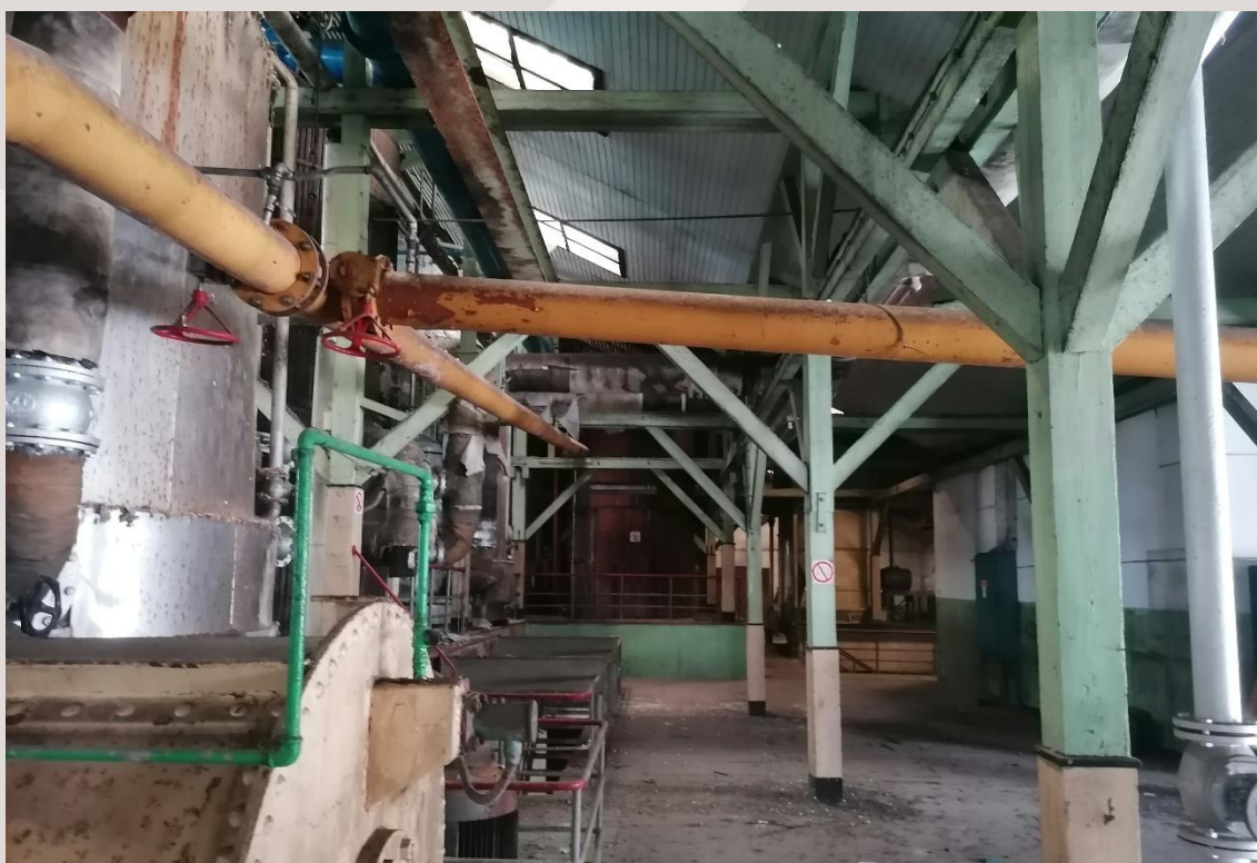
Figura 55 – Interior do edifício da antiga Fábrica (edifício 8).
