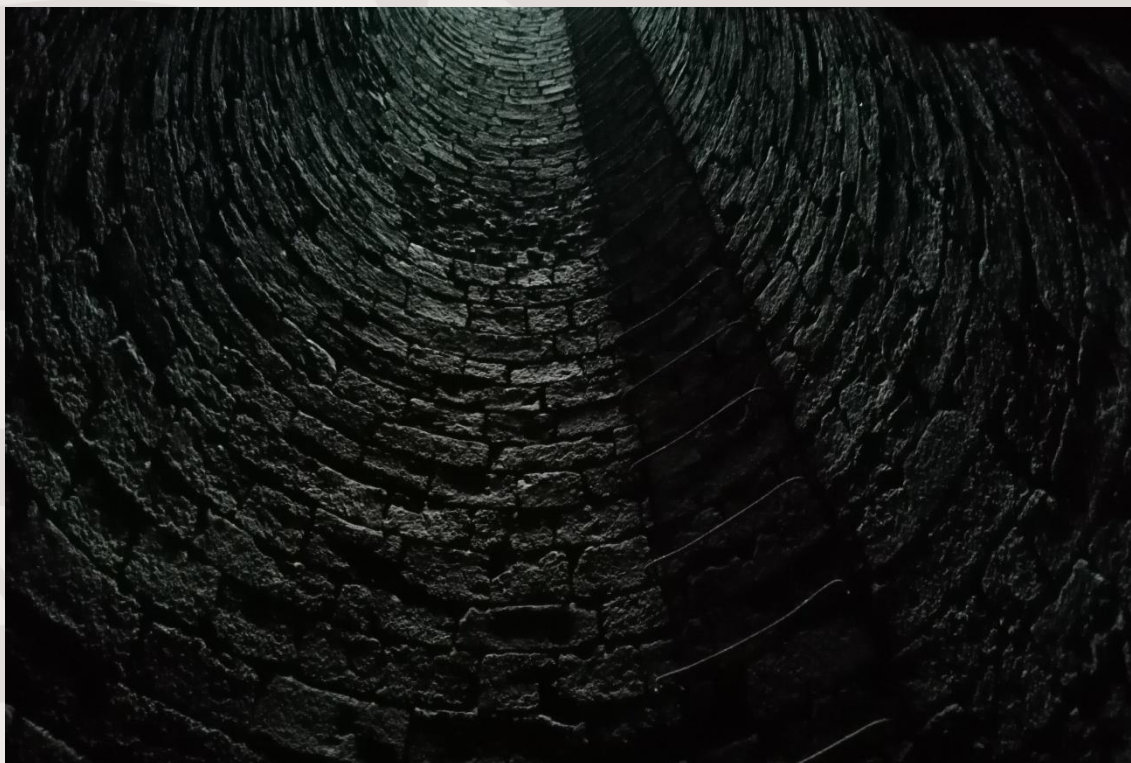
Figura 66 – Interior da chaminé de pedro de basalto (edifício 8.5).
