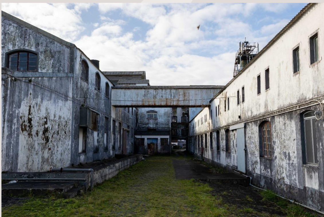
Figura 53 – Vista exterior da antiga Fábrica (passagem entre o edifício 8 e o edifício 9). Autor: Hugo Moreira
