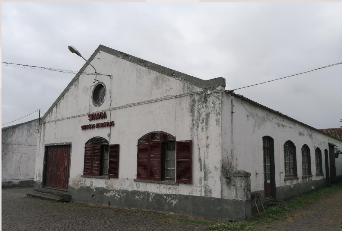
Figura 63 – Vista exterior do edifício dos escritórios dos serviços agrícolas (edifício 6).
