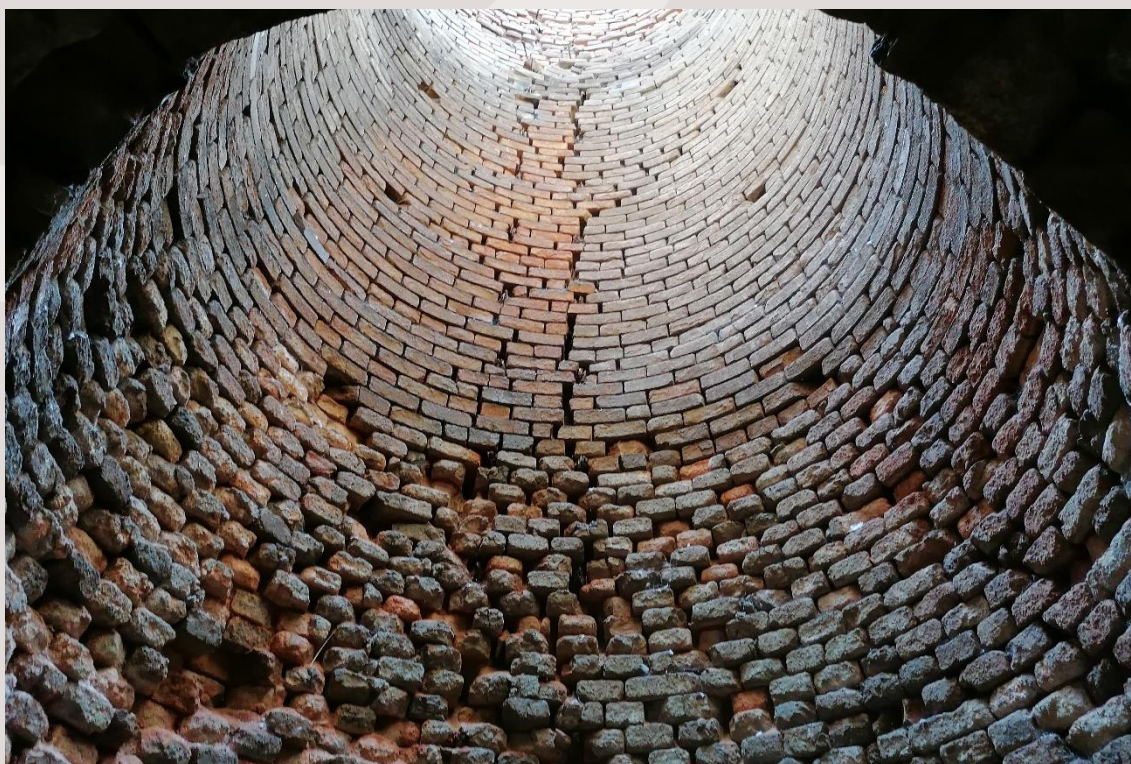
Figura 67 – Interior da chaminé de tijolo (edifício 8.6).
