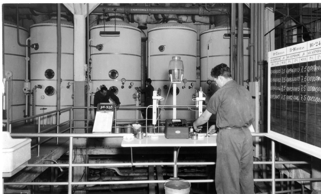
Figura 89 – Aparelho de “Múltiplo-efeito” (para concentrar xaropes a baixa temperatura). Fonte: Espólio da SINAGA a/c do Museu Carlos Machado.
